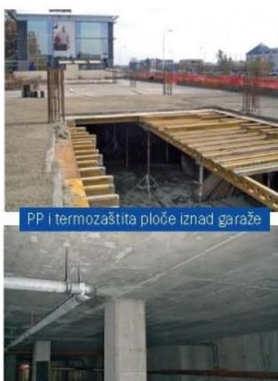
sa dva sloja - termoizolacionim slojem od mineralne vune sa parnom branom od polietilenske folije i spuštenim plafonom od tri sloja vodootpornih gipskartonskih ploča koji poseduju atest vatrootpornosti na zahtevanih 120 minuta.
