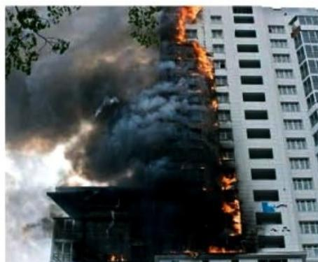
konstrukcije. Kao primer, nedavno se u Moskvi, na objektu u izgradnji na kojem su se izvodili završni radovi na termoizolaciji i hidroizolaciji krova, upalio bitumen uskladišten na poslednjem spratu, krovna ploča od ošupljene prednapregnute tavanice iznad se prvo nekontrolisano deformisala, a zatim uz ogroman tresak srušila, lomeći svih osam međuspratnih
