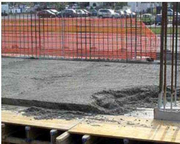
*Beograd: Simprolit monolit kao PP zaštita i podloga međuspratne ploče iznad garaže stambenog objekta*
