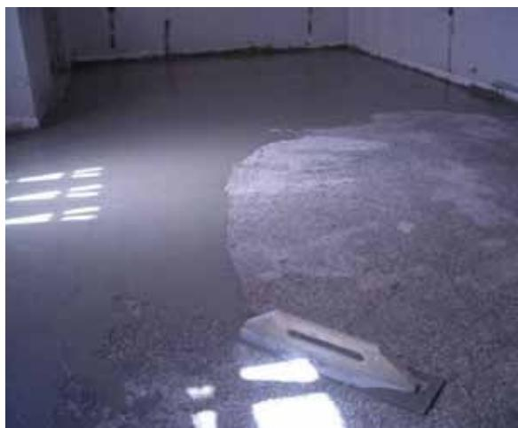
Beograd: izvođenje Simprolit cementne košuljice u stambenom objektu
