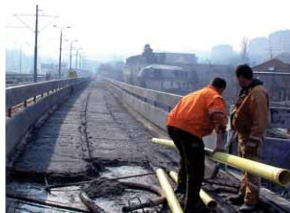
*Beograd: Autokomanda, pešački i tramvajski most Simprolit® monolit zapreminske težine 350kg/m<sup>3</sup>, čvrstoća na pritisak >1.4MPa*
