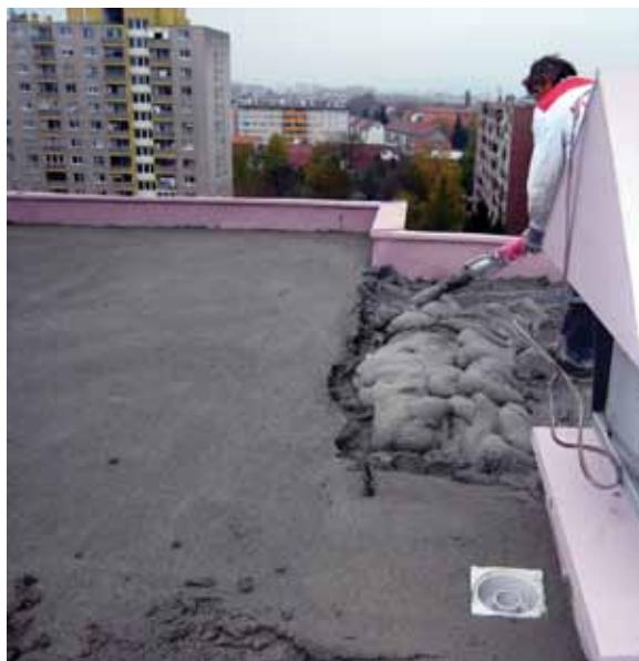
*Slovenija: Simprolit monolit kao termička zaštita, sloj za pad i osnova hidroizolacije ravnog krova*
