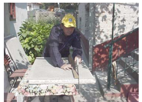
6. Sečenje - ukrajanje ploča običnom lisnom testerom
