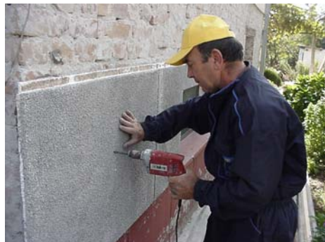
5. Bušenje rupa za tiplove dubine d_{pl} + 5 cm
