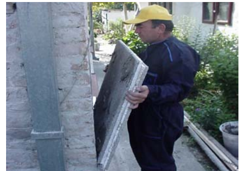
3. Postavljanje ploče blagim pritiskom na zid
