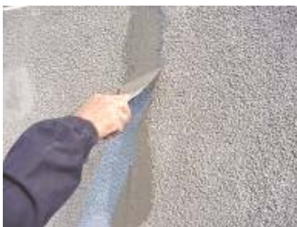
16. Bandaž traka u lepku na spojevima ploča
