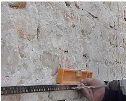
1. Postavljanje osnovne lajsne limeni »U«, »Z« ili »L« profil
