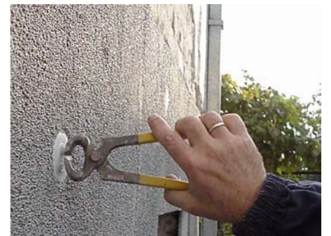
9. Sečenje preostalog dela plastičnog klina
