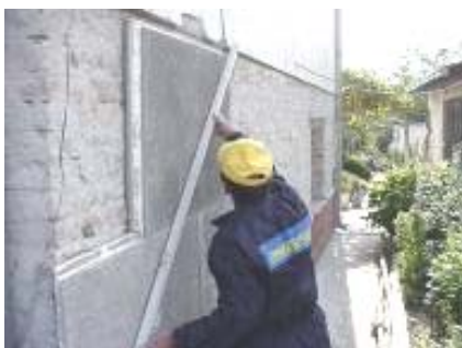
10. Ravnanje ploča po zidu u svim pravcima
