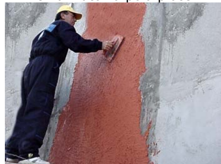
18. Nanošenje završne fasadne obrade
