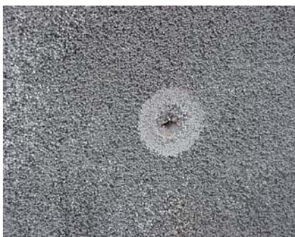
7. Obrada za šejir tipla glodalicom ili brusilicom
