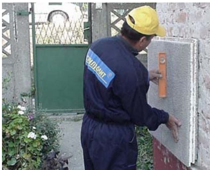
4. Ravnanje ploče po vertikalnosti fasade
