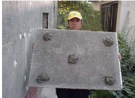
2. Nanošenje lepka gušće konsistencije
