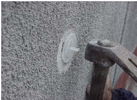
8. Postavljanje plastičnog tipla sa plastičnim klinom
