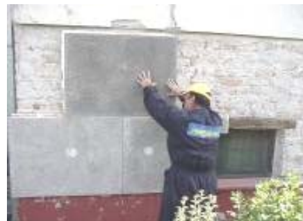
15. Drugi red ploča postaviti smaknuto za pola ploče
